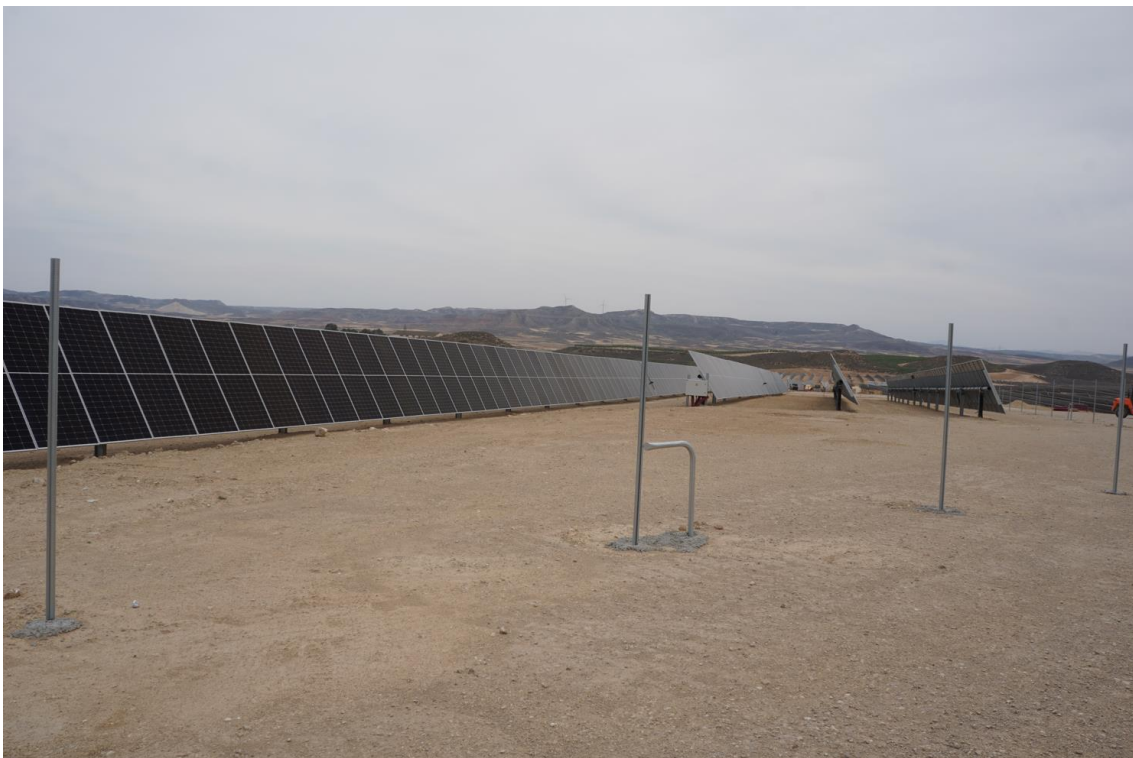
Figura 4 Instalación de pasos de fauna en el vallado
