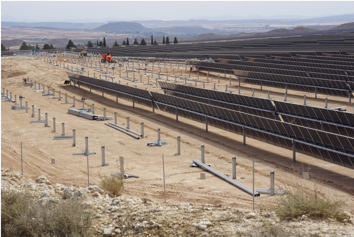
Figura 8 Seguidores por instalar en Plana de la pena 1
