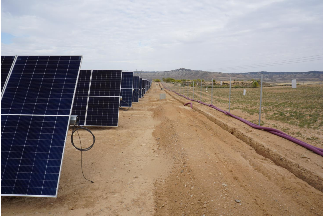
Figura 6 Excavación de zanja en limite este de Plana de la Pena 1
