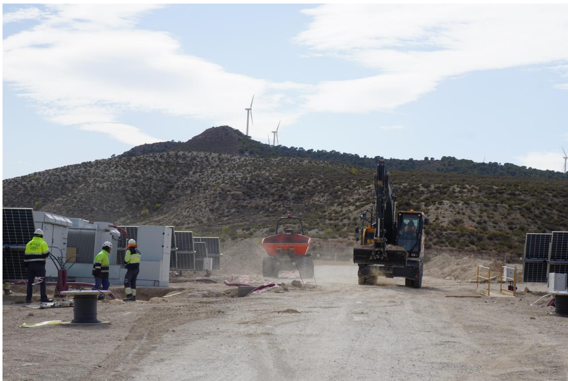
Figura 2b Instalación de cuadros eléctricos en Plana de la Pena 1
